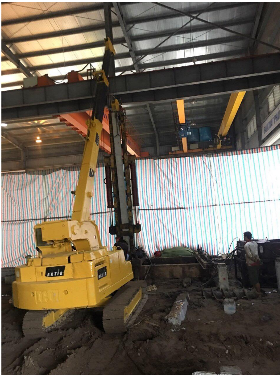
Thi công ép cọc U200: Medlac Pharma Italy – KCN Hòa Lạc
