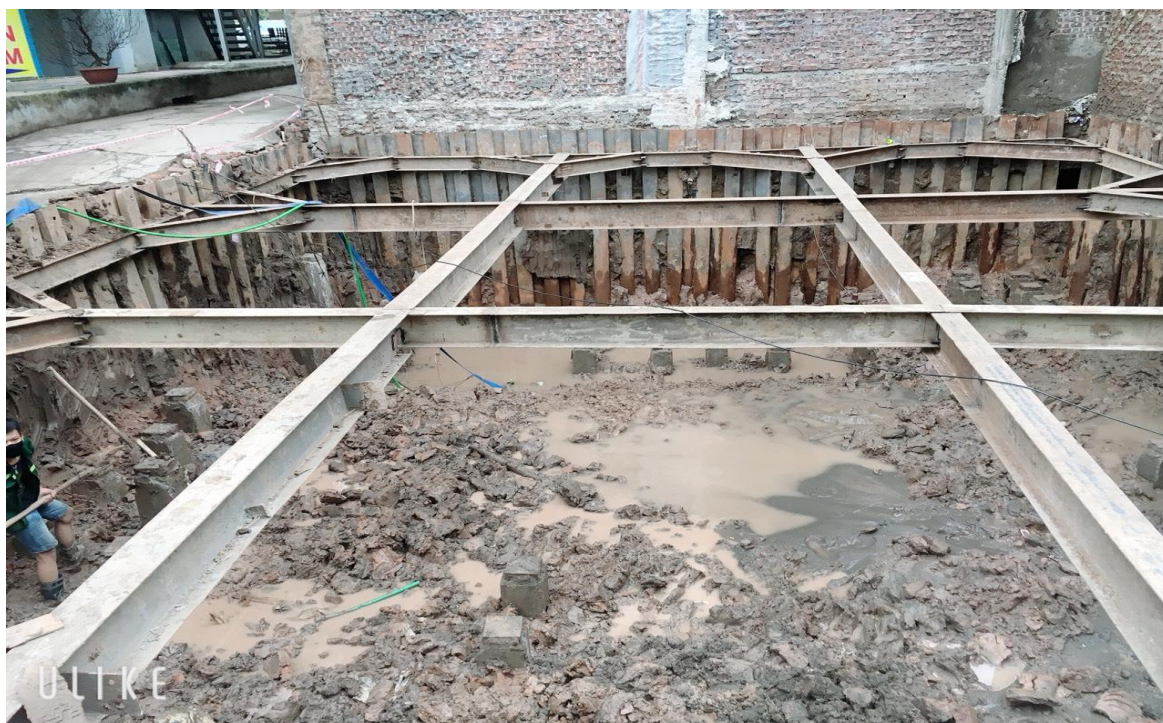
Thi công ép cừ U nhà văn hóa
