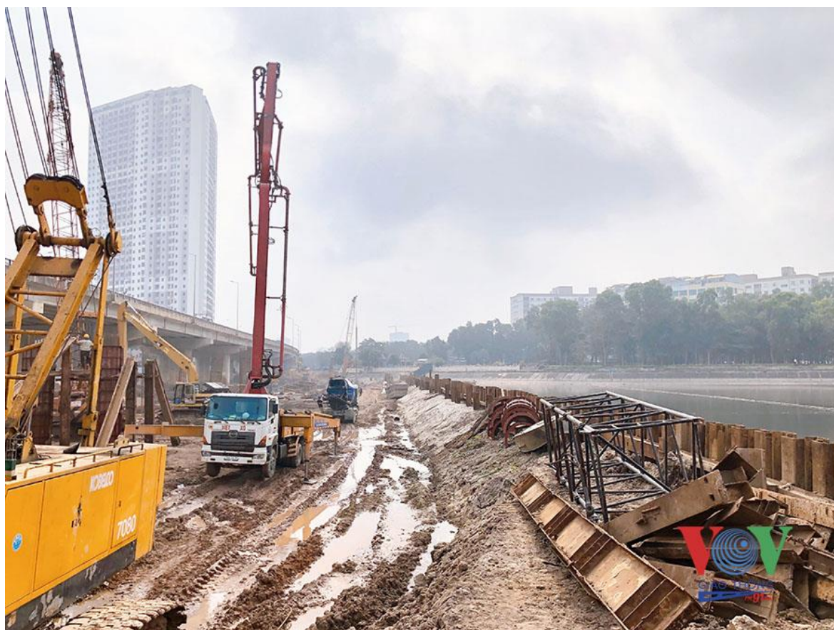
Thi công cừ Larsen Gối Thâu: Cầu vượt thấp qua hồ Linh Đàm – Hà Nội
