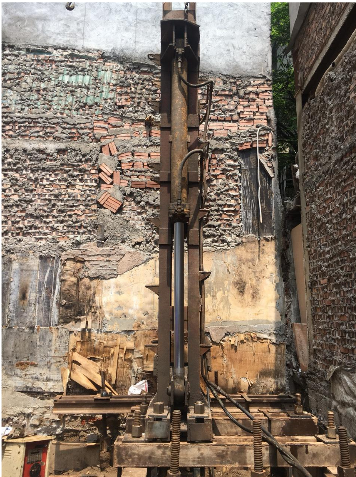
Thi công ép cừ U: Trường Trung cấp nghề số 1 Hà Nội
