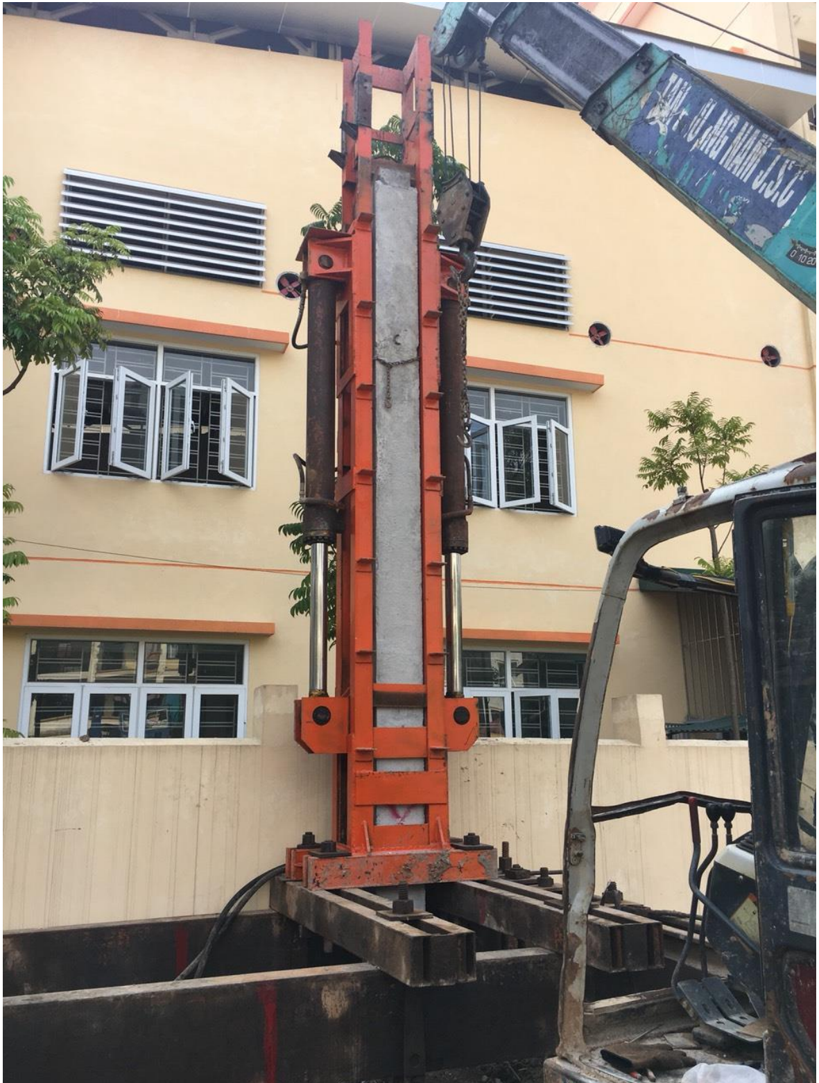
Thi công ép cừ U200 Trụ sở Tòa soạn báo Văn Nghệ - Hà Nội
