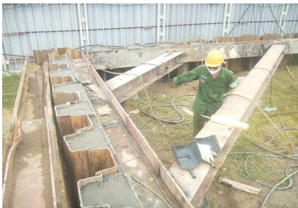
Công trình: Trạm xử lý nước thải nhà máy Canon
