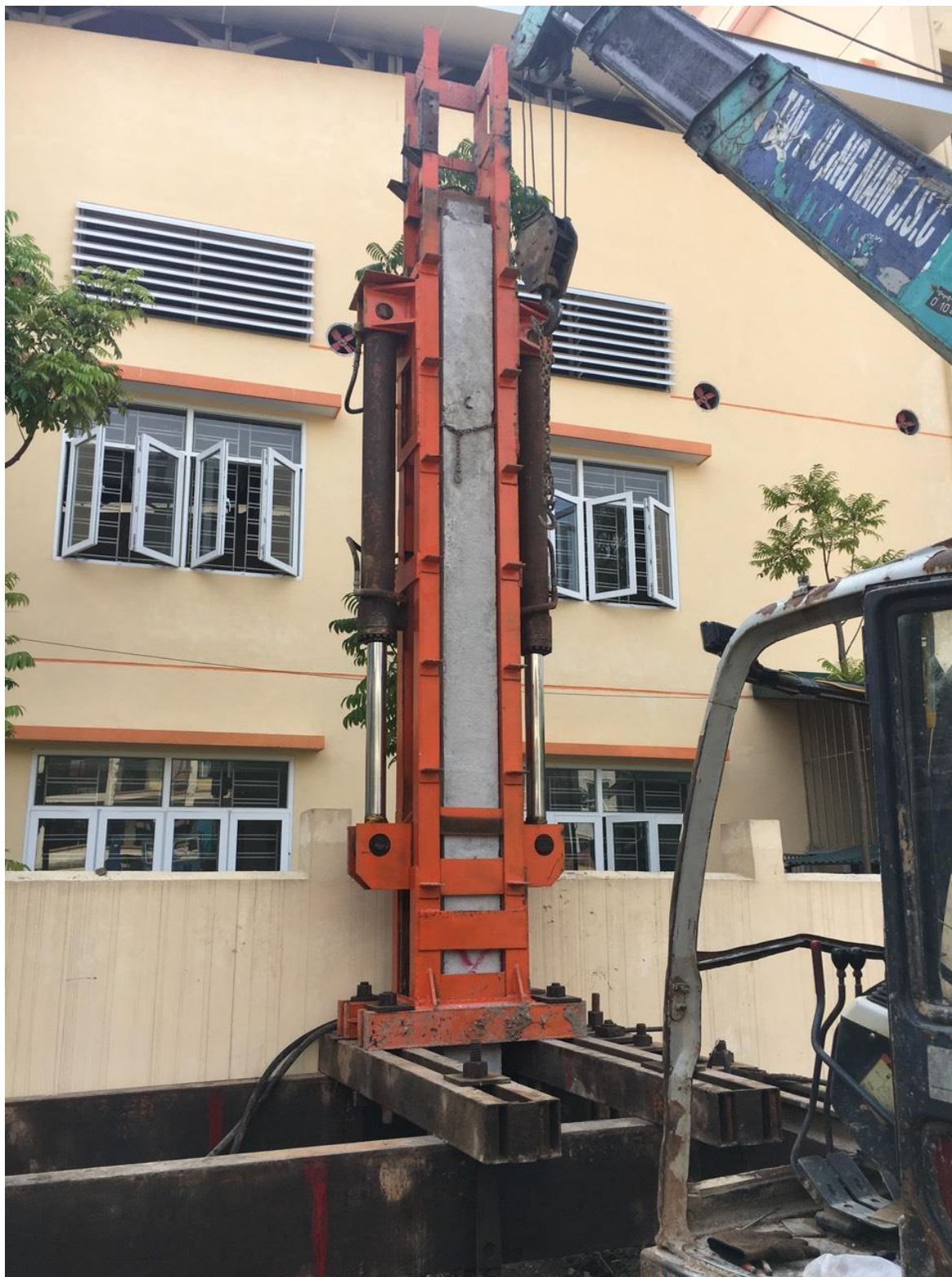
Thi công ép cừ U trụ sở Tòa soạn báo Văn Nghệ Hà Nội
