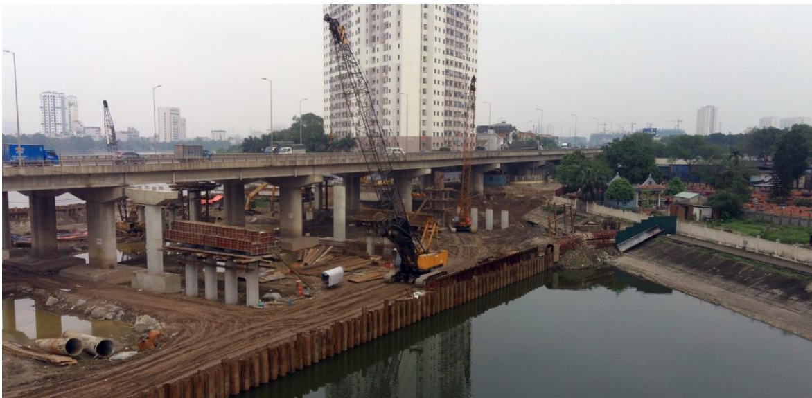
Thi công cừ Larsen Gối thầu: Cầu vượt thép qua hồ Linh Đàm – Hà Nội
