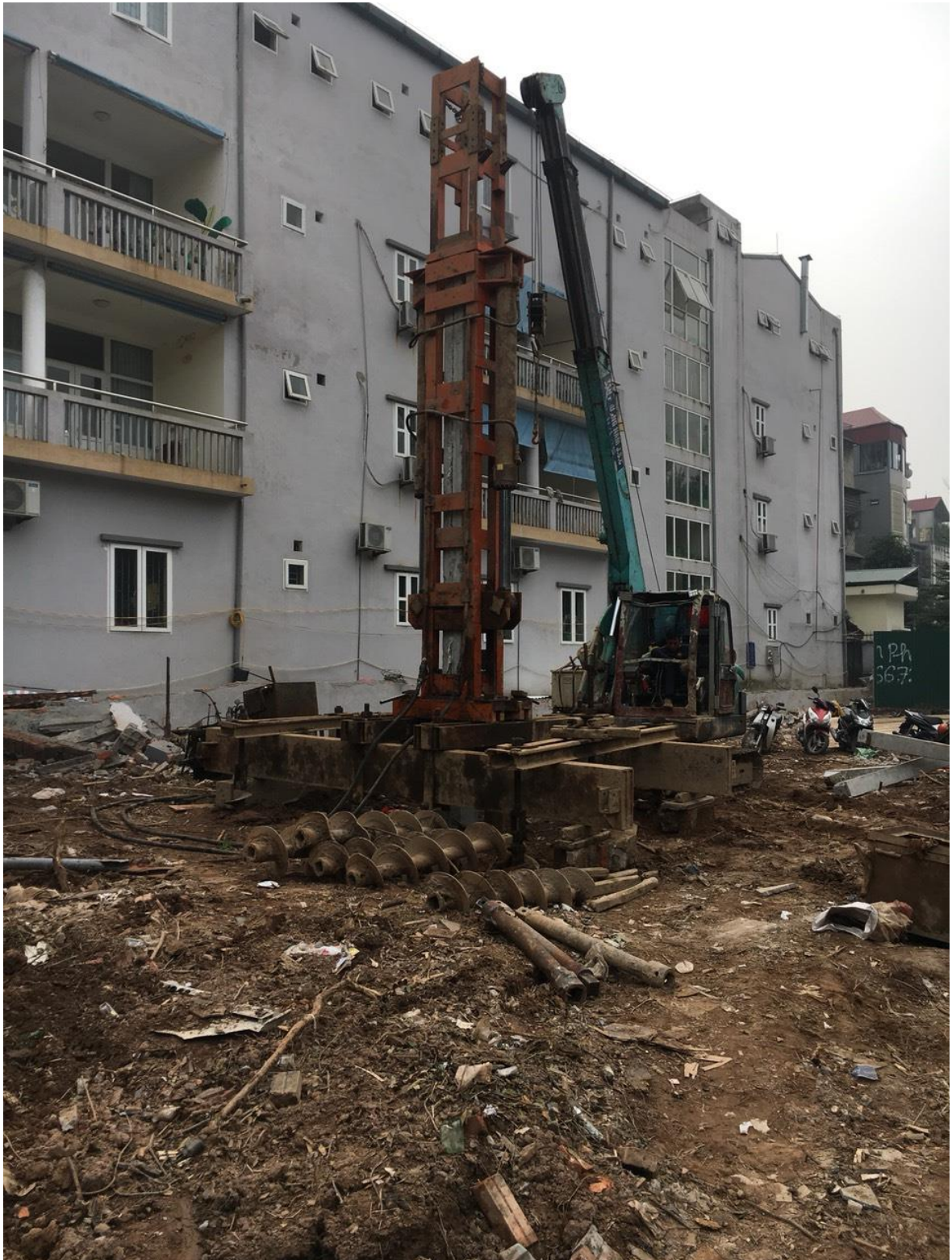
Thi công ép cọc U: Nhà ở thấp tầng N0-06B KĐT Việt Hưng – Long Biên
